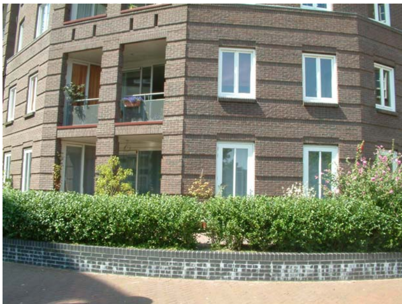
Figuur 3 – Een fraai voorbeeld van de toepassing van rollagen treffen we aan in woningbouwproject ‘De Meander’ in Amsterdam van architect Krier. Het metselwerk boven en onder de kozijnen is afgewerkt met een rollaag, zoals ook bij de loggia’s. De gevels zijn verder verdeeld in horizontale stroken metselwerk door een terugliggende rollaag.
