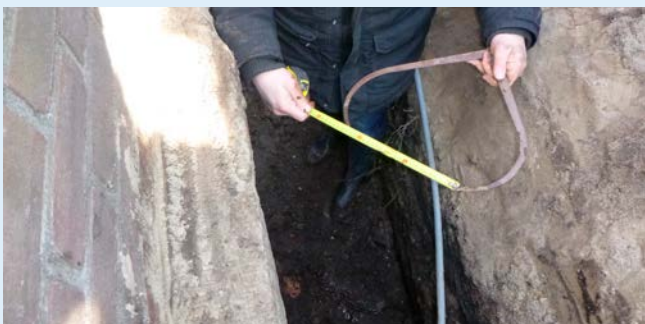
Figuur 46: Krompasser: paal-diameter (BVL)
