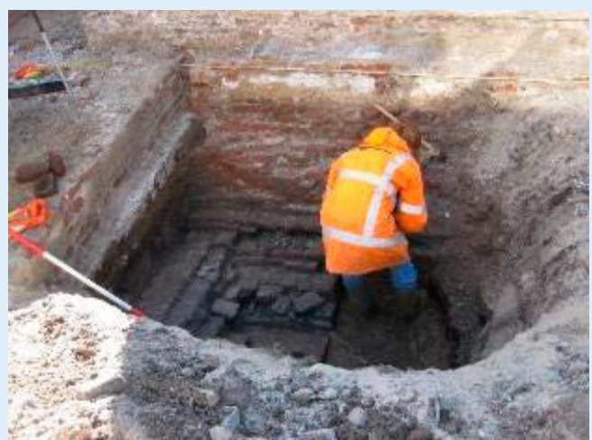
Figuur 43: Metselwerk bij een fundering op staal (Fugro)
