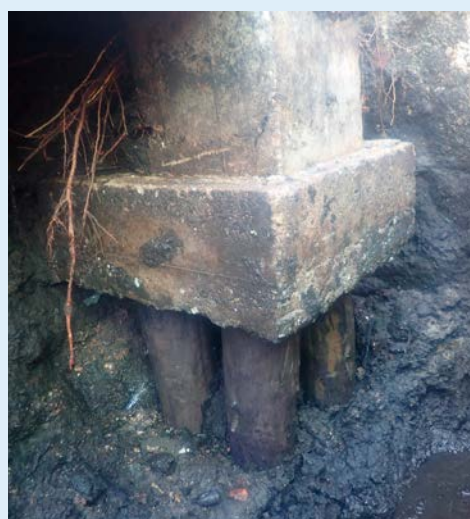
Figuur D3: Poerenfundering (Fugro)
