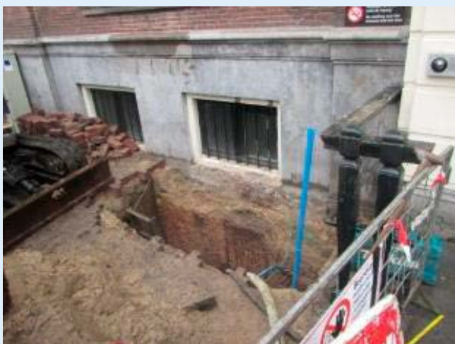
Figuur 42: Metselwerk bij een paalfundering en peilbuis voor lokale grondwaterstandsmeting (Aveco de Bondt)
