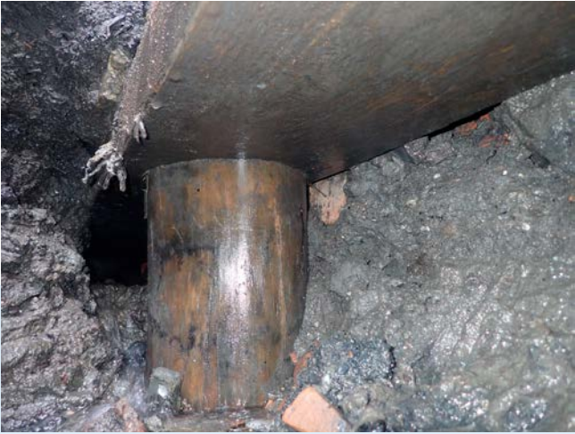
Figuur 8 en 9: Links funderingstype A: Rotterdamse fundering en rechts funderingstype B: Amsterdamse fundering (Fugro)
