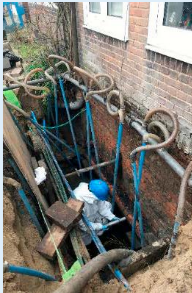
Figuur 40: Kwaliteit metselwerk en meting met inslaghamer (Fugro)
