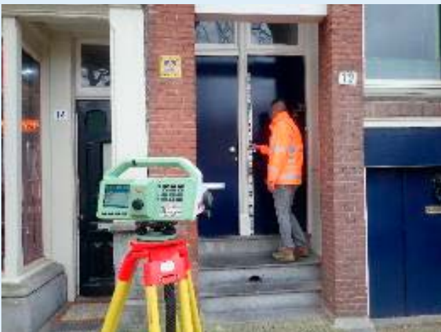
Figuur 28: Peilmaat op kozijndorpel voordeur (Fugro)
