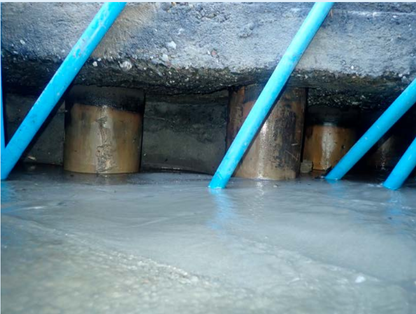
Figuur 10 en 11: Links funderingstype C: houten paalfundering onder een beton balk en rechts funderingstype D: houten paalfundering met betonopzetter (Fugro)
