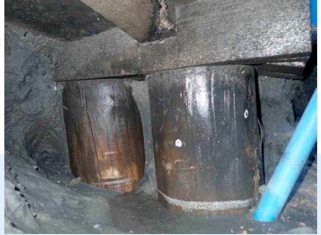
Figuur 8 en 9: Links funderingstype A: Rotterdamse fundering en rechts funderingstype B: Amsterdamse fundering (Fugro)
