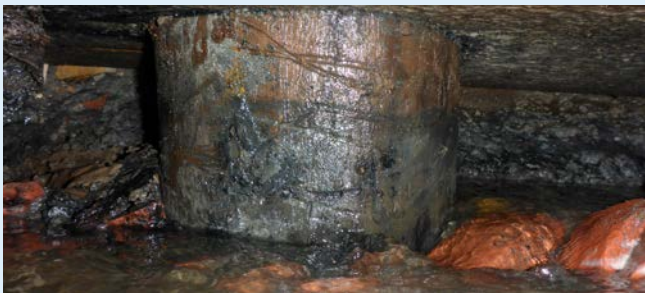
Figuur 44: Houten funderingsconstructie in goede conditie (BVL)
