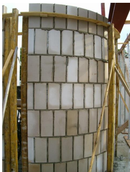
Verticaal vermetselde lijmblokken.
