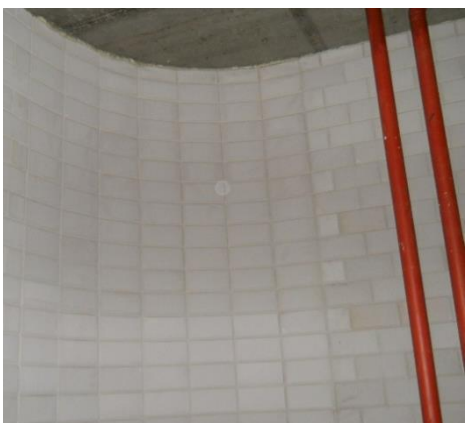
Ronde wanden met vellingblokken in staand verband.
